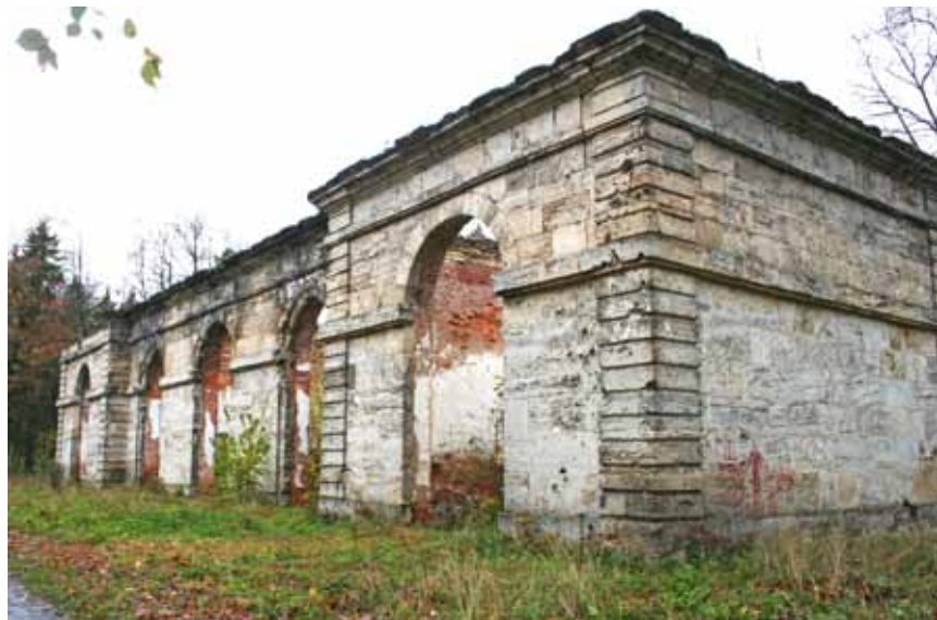
Илл. 1. Здание Лесной оранжереи. Современное фото
