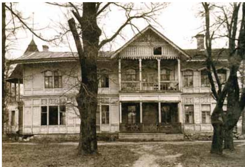
Илл. 5. Бывшая дача М.Ф. Кшесинской в Стрельне. Вид южного фасада здания. Фотография. Кон. 1940-х. Частный архив
